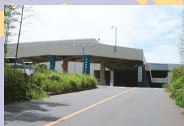
Нарита (Глобальный распределительный центр: ГРЦ)
